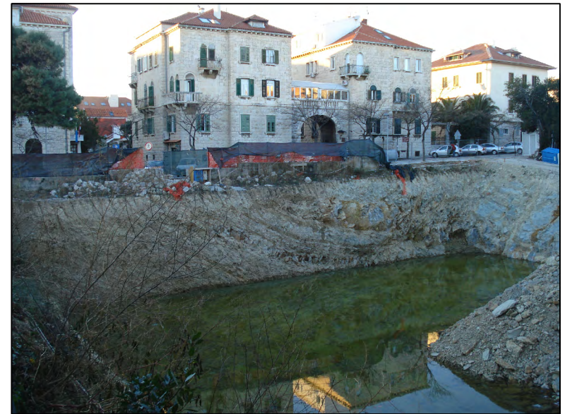
Pogled na sjeverozapadni rub čestice
