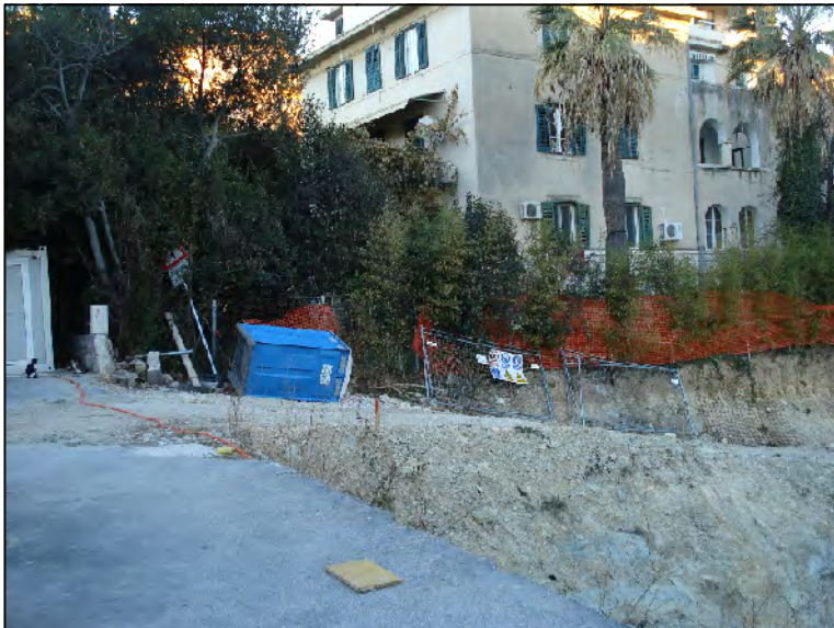
Stambena izgradnja uz sjeverozapadni rub čestice
