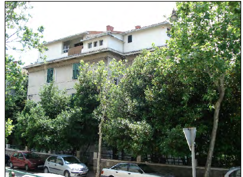
Pogled iz Gupčeve ulice na sjeverno pročelje stambenog objekta uz sjeverni rub čestice
